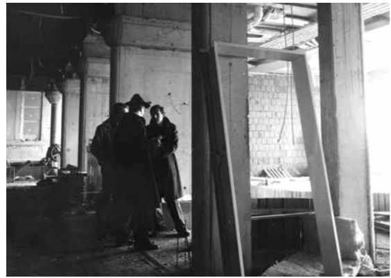
Rohbaubesichtigung der Therme Parkhotel
